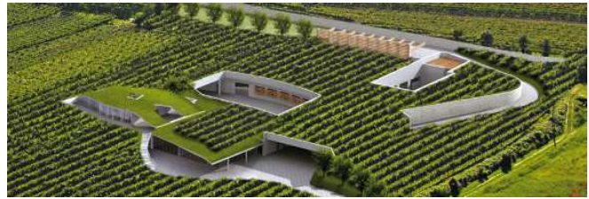
Figura 11-Cantina eco-sostenibile con struttura ipogea (fonte http://www.cantinamoricollizugna.it/images/sostenibilita.jpg )
