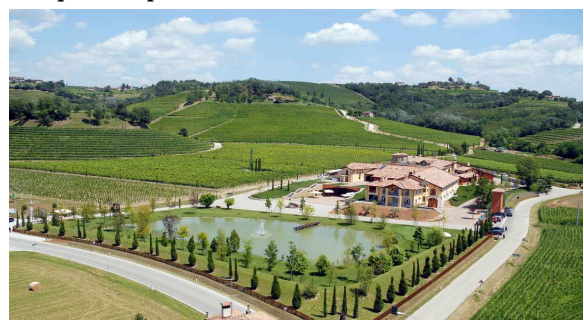
Figura 12-Cantina dotata di bacino per accumulo delle acque piovane e sistema di fitodepurazione (fonte http://www.agenziacasaclima.it/images/content/143346_16440_2_S_0_600_0_2628224/jermann-ruttars1.jpg )
